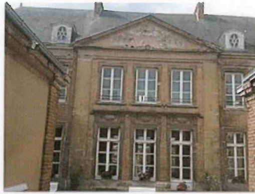
La façade orientale.
